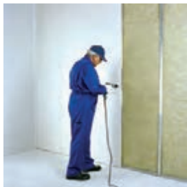
اجرای پانل‌ها در دو طرف دیوار
