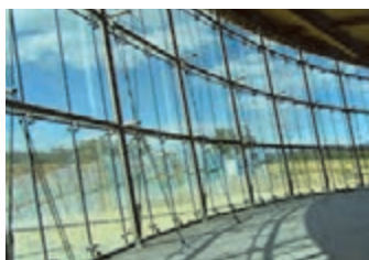
نمای شیشه‌ای با سیستم اسپایدر (سیستم عنکبوتی)
