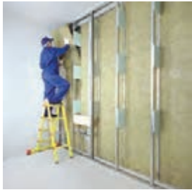
اجرای پانل‌ها در یک طرف دیوار اجرای عایق معدنی
