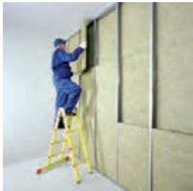
اجرای عایق پشم معدنی
