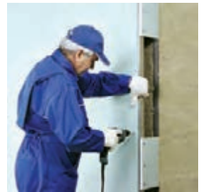
اجرای پانل‌ها در طرف دیگر دیوار
