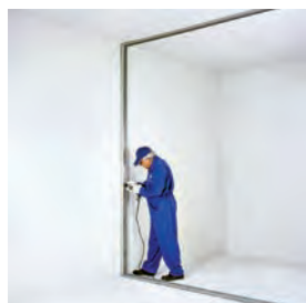
نصب استاد بر روی ساختار جانبی
