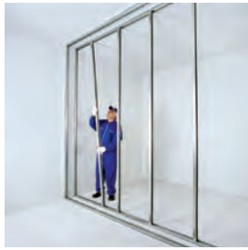
اجرای ردیف اول استاداها
