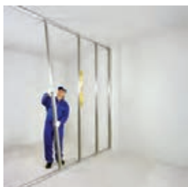
اتصال استاد به دیوار بنایی با اجرای استاده‌ها (به صورت شاقولی) رول پلاک
