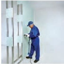
اجرای پانل‌ها در یک طرف دیوار اجرای عایق معدنی
