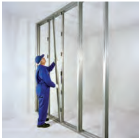
اجرای ردیف دوم استاداها
