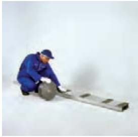
اجرای نوار عایق بر روی استاداها
